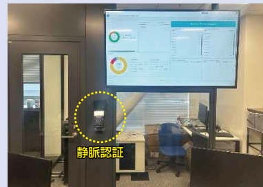
サーバールームを室内に設け遠隔設定や迅速な状況確認を可能としている
