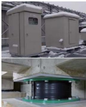
自社専用の自家発電機を装備。ビル自体は免震構造を備え、もしもの場合の安全・安心を確保
